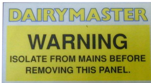
Abbildung 12 - Warnaufkleber am Transformatorkasten
